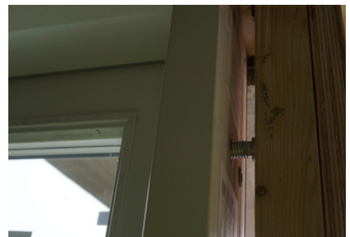
Kuva 2. Karmin asennus Adjufix-holkillä.
