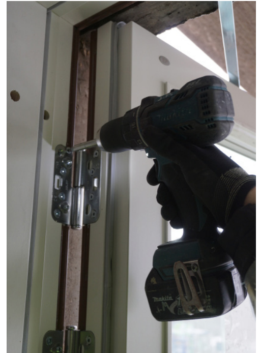
Kuva 3. Karmin kiinnityksen varmistusruuvi.
