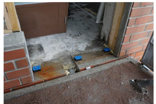
Kuva 1. Korkopaloina voidaan käyttää korkoruuveja tai asennuskiiloja (kuvassa).
