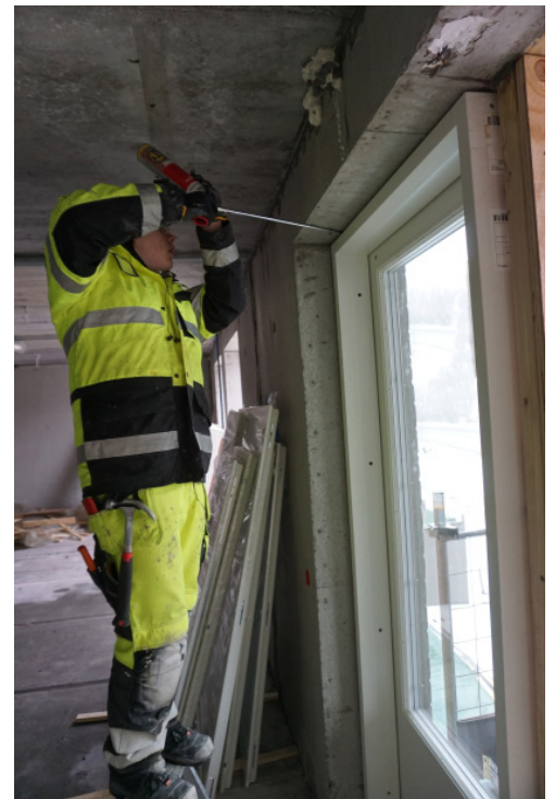
Kuva 4. Uretaania vaahdotetaan n. 2/3 karmisyvyydestä.
