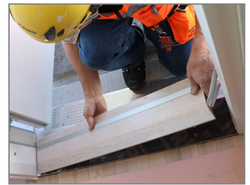
Kuva 2. Tarkistetaan kynnyksen sopivuus paikalleen.
