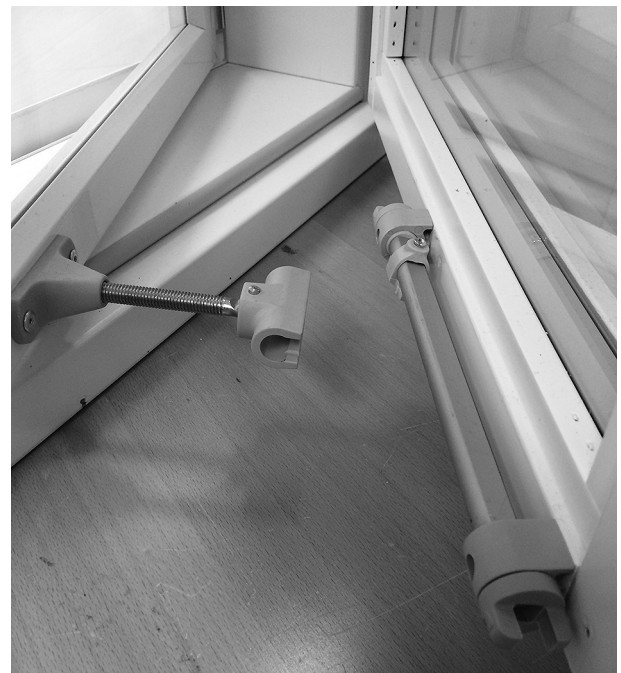
Liukukiskon lukitusvipu vaakasuunnassa (vapautettuna).
