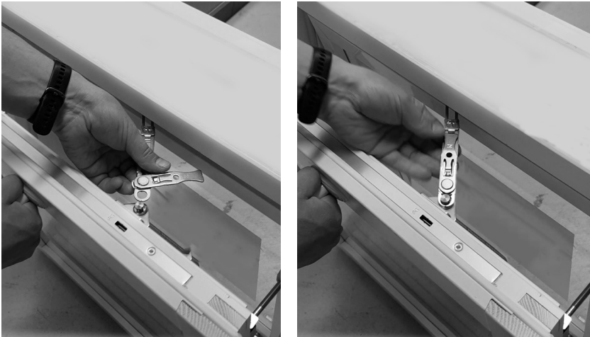
Kuva 3. AVR-lisärajoittimen vapautus ja kytkentä.
